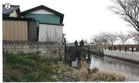
液状化の影響で堀に亀裂が入ったほか、建物も川に向かって引きずられていた（側方流動。25・27頁）。対岸の護岸にも損傷が見受けられる
